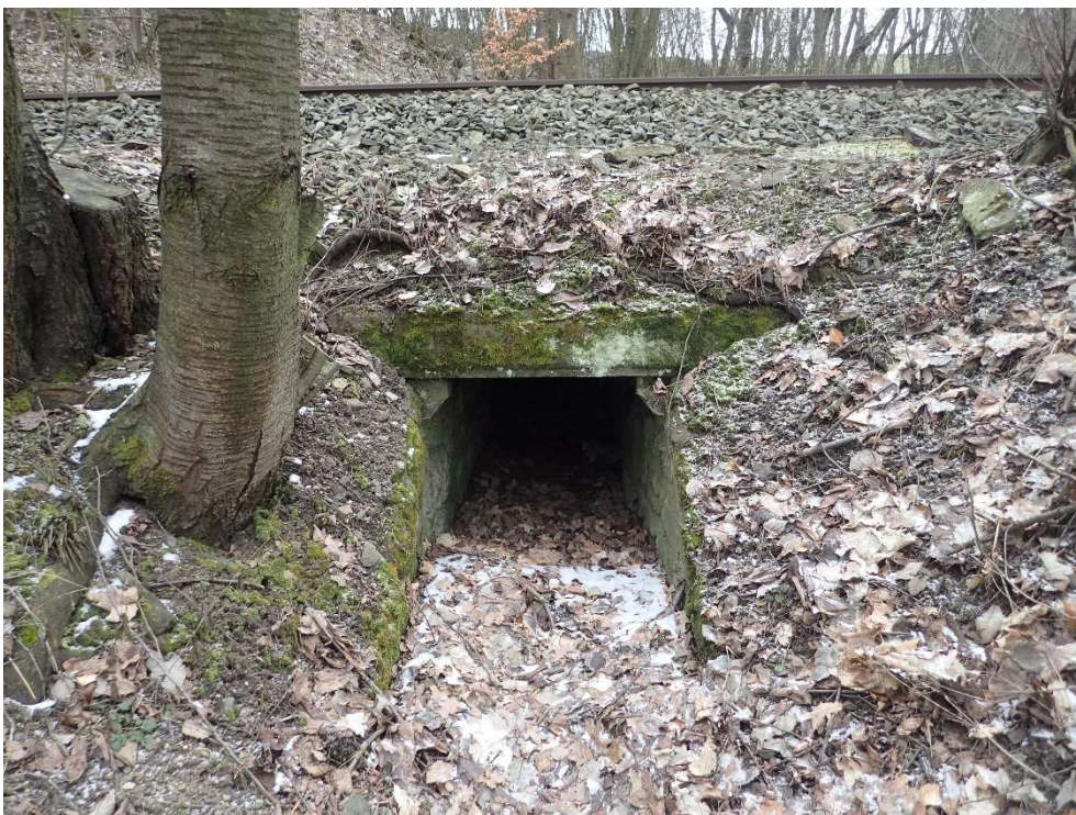
Foto 3: Pohled na zanesenou výtokovou stranu propustku
