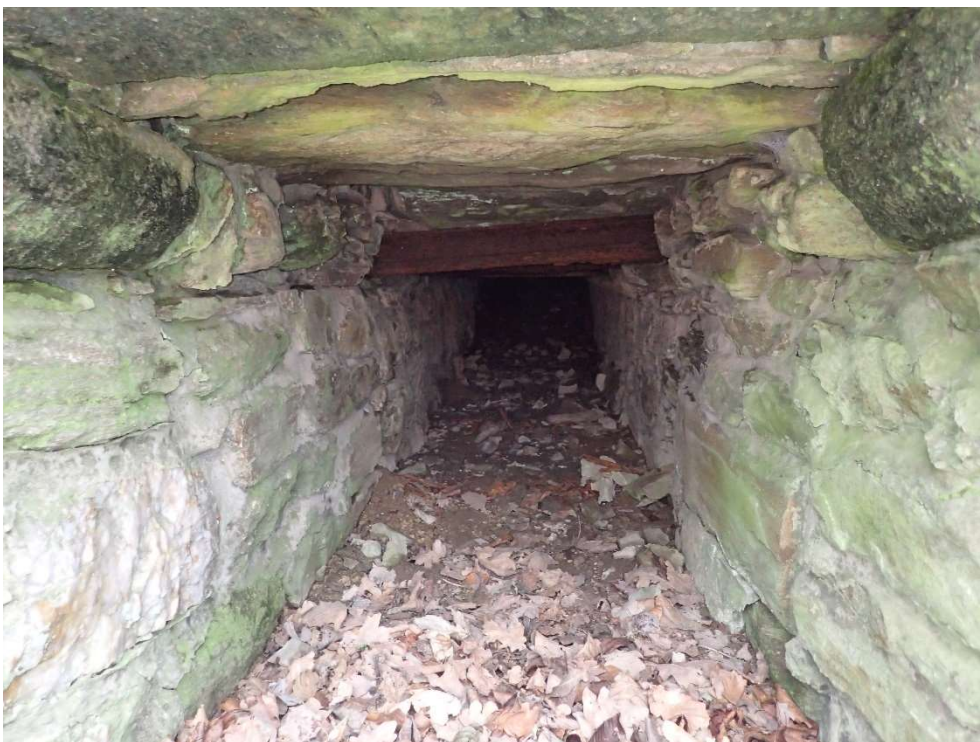
Foto 4: Detailní pohled – degradování kamenné desky, koroze
