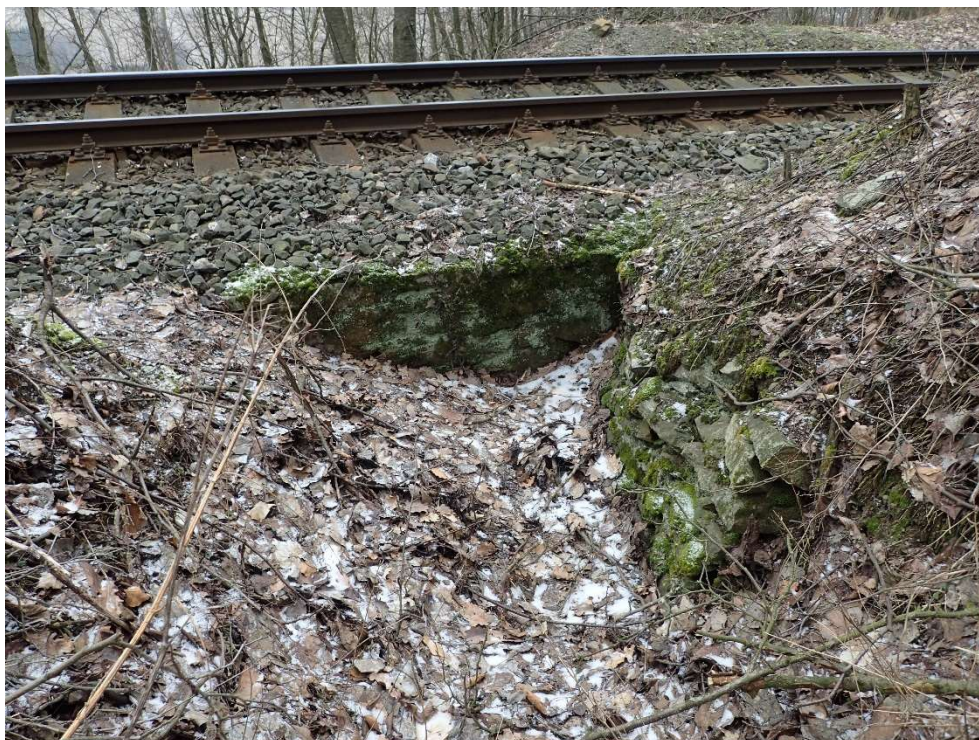
Foto 1: Pohled na zcela zanesenou vtokovou stranu propustku
